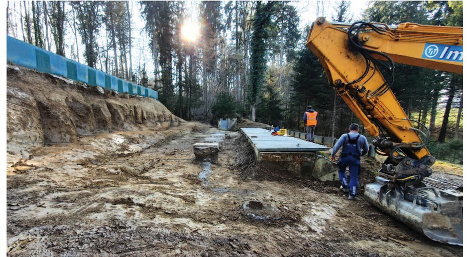
Da die bestehenden Kugelfangkästen schon grössere Abnutzungserscheinungen zeigten und eine umfassende Sanierung anstand, hatten wir uns zum Austausch der Anlage und zu einem Wechsel auf das Zyklon-System der Firma Marep AG entschieden. Die Kosten lagen mit Fr. 43 400.- wesentlich höher als die einer Sanierung, können aber zukünftig durch den geringeren Unterhalt wieder amortisiert werden.
