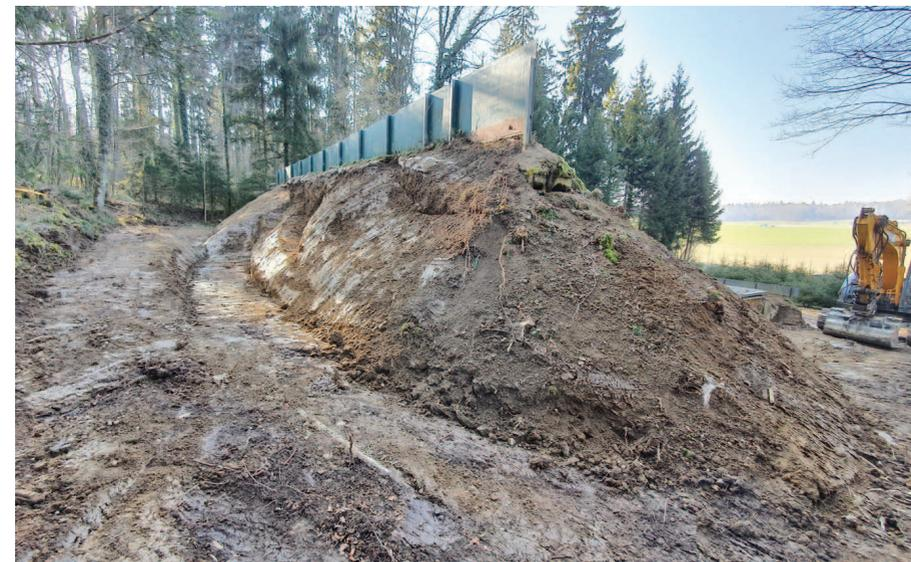
Im März 2022 wurde die eigentliche Sanierung durchgeführt. Dank der trockenen Witterung beschränkte sich der Einsatz auf 4 Wochen. Dabei wurden insgesamt 625 Tonnen Erdmaterial ausgehoben und abgeführt. Fast 95 % oder 590 Tonnen des Materials konnte nicht einfach deponiert werden, sondern musste bei der Firma Toggenburger einen speziellen Reinigungsprozess durchlaufen. Alleine diese Reinigungs-Kosten betragen Fr. 110 000.–.
